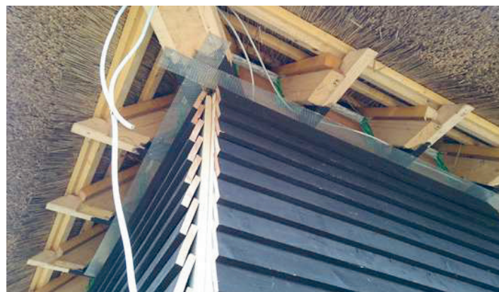
Bauphase, Foto: © Straub Beutin Architekten, Berlin
