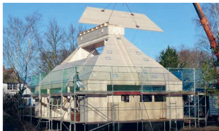
Bauphase, Foto: © Straub Beutin Architekten, Berlin
