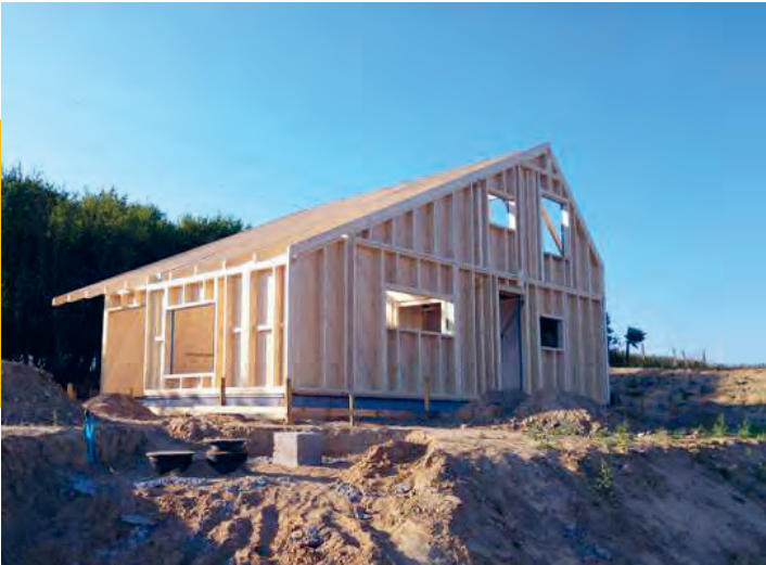
Bauphase Haus Malsehn, Foto: © René Witt
