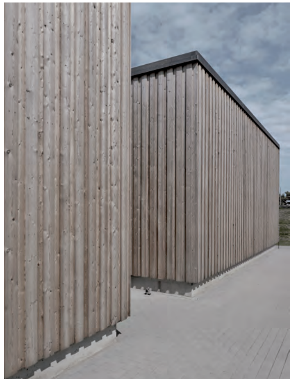
Fassade verkleidet mit witterungsbeständiger sibirischer Lärche, Foto: © W&V Architekten GmbH, Leipzig/ Berlin
