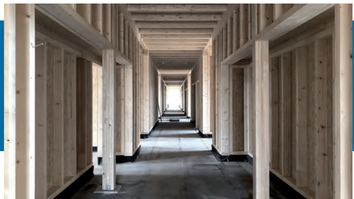
Vorgefertigte hölzerne Tragkonstruktion der Module, Foto: © W&V Architekten GmbH, Leipzig/ Berlin
