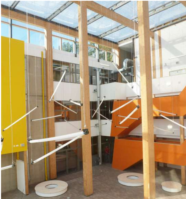
Innenansicht Eingangshalle/ Marktplatz, Foto: © Martin Wollensak
