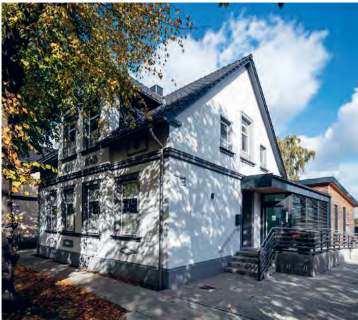
Außenansicht Bestandsgebäude mit Anbau, Foto: © Jörn-Lehmann-Photographie, Zittow
