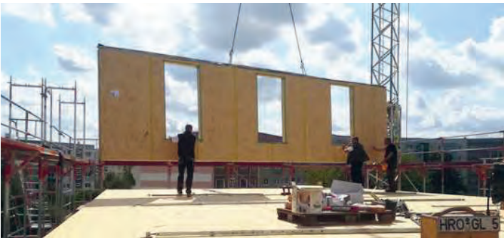
Bauphase, Foto: © matrix architektur gmbh, Rostock
