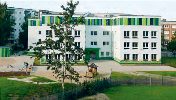
Nach der Sanierung, Foto: © Anja Schlamann
