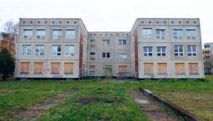
Bestand, Foto: © matrix architektur gmbh, Rostock
