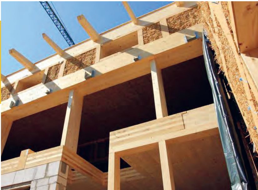
Bauphase – Holzkonstruktion, Foto: © Dag Schaffarczyk, Berlin
