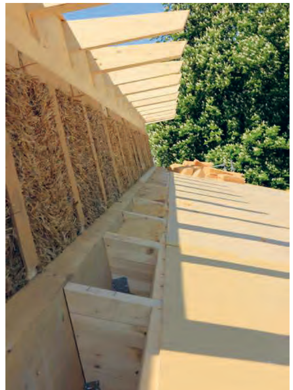
Bauphase – Detail Dach, Foto: © Dag Schaffarczyk, Berlin
