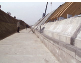
Betonaufleger, Kämpfer ohne Hinterfüllung
