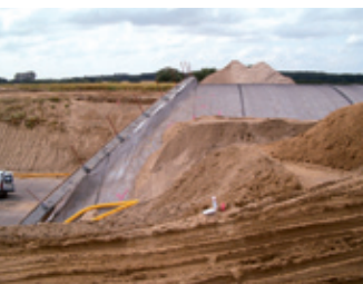
Auflager hinterfüllt
