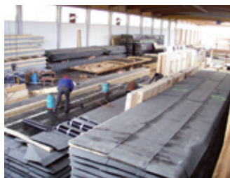
Vormontage der Elemente
